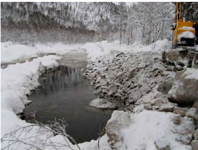
Figur 38 : Bilder fra forbygning i Hundsåa 2007.
