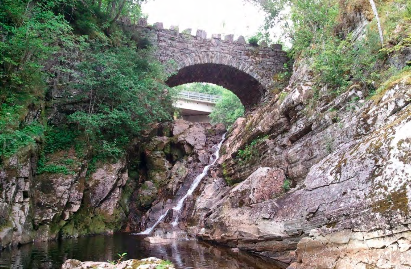
Figur 34 : Anadrom sperre ved Eidsfossen 12.8.2010
