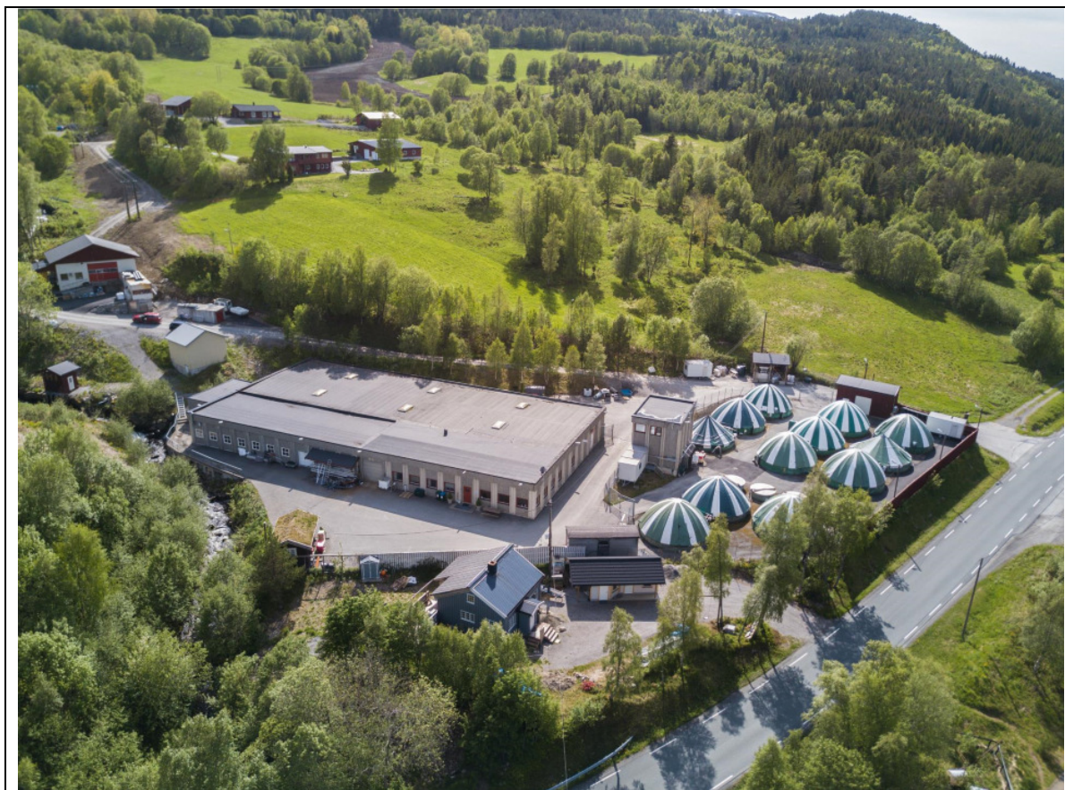
Skråfoto av situasjon på gnr. 137./ bnr.2, 26, 27
