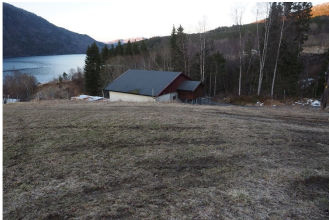
Fra sør-vest mot kraftverket
