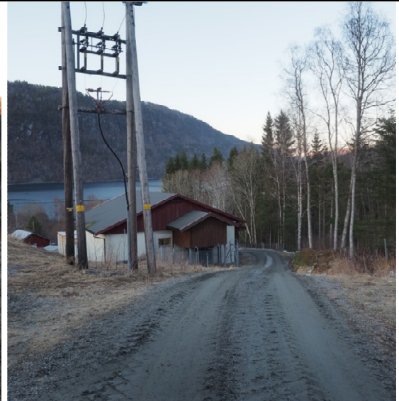
Eksisterende høyspentlinje og Haukvik Kraftverk
