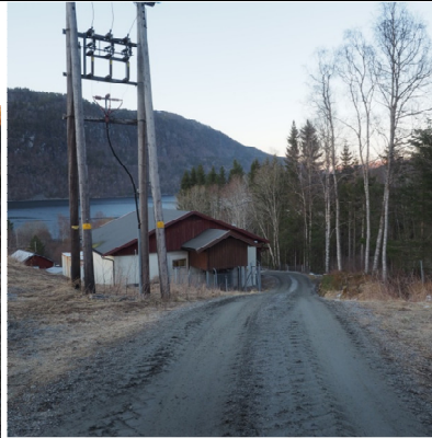
Eksisterende høyspentlinje og Haukvik Kraftverk
