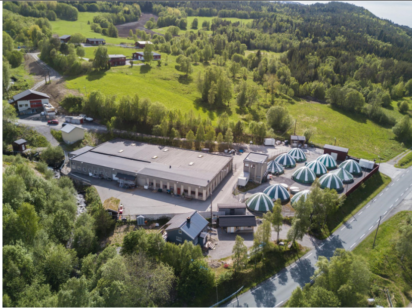
Skråfoto av situasjon på gnr. 137./ bnr.2, 26, 27
