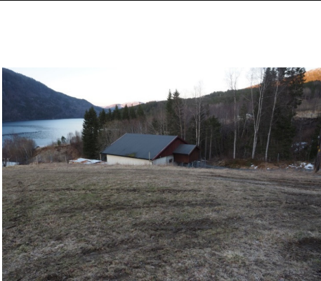
Fra sør-vest mot kraftverket
