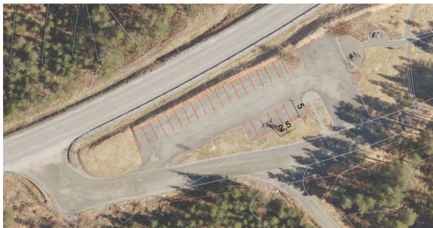
Figur 4-1: Flyfoto dagens situasjon m/ parkeringsplasser
