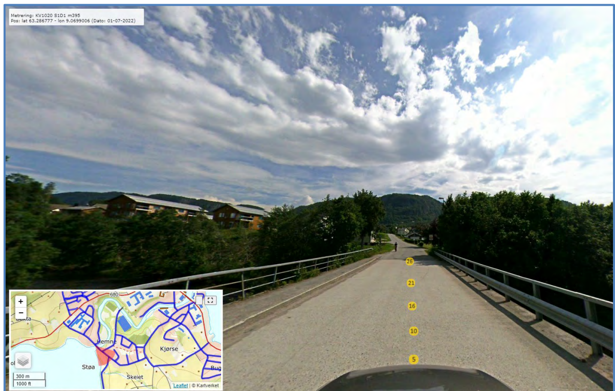
Foto: Kv1020 Støa
