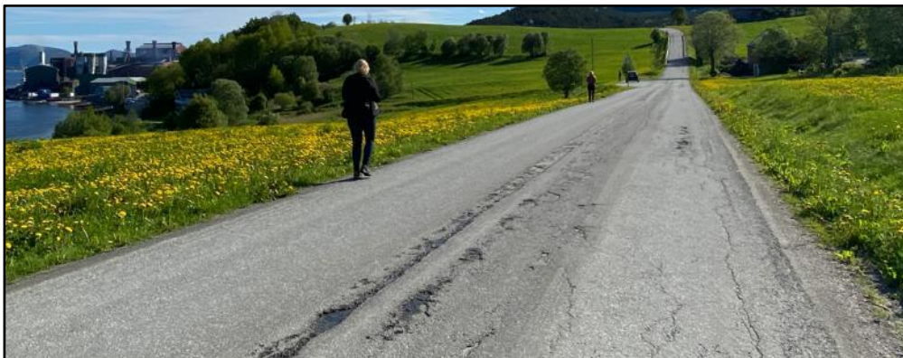
Figur 4-21: Synlig dekkeskade på fv. 6432 vest for atkomst til anlegget. (Foto: Norconsult, mai 2022)
