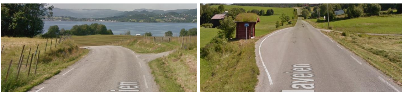
Figur 11 Til venstre: Krapp kurve etter lang rettstrekning sett mot vest like øst for Spjøtvollan. Til høyre: Kort ensidig busslomme for buss i retning vest, øst for Spjøtvollan. (Google Street View 2019)
