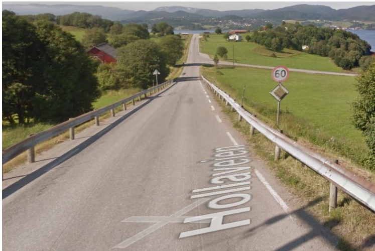
Figur 9 Fv. 6432 sett mot vest i retning kryss med atkomstveg. Over 10 % stigning/fall og smalt mellom rekkverk (Google Street View 2019)
