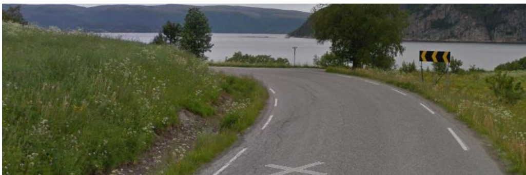
Figur 7 Eksempel på sammensatt kurve med radius 38 / 49 meter ved Vollaneset (Google Street View 2019)
