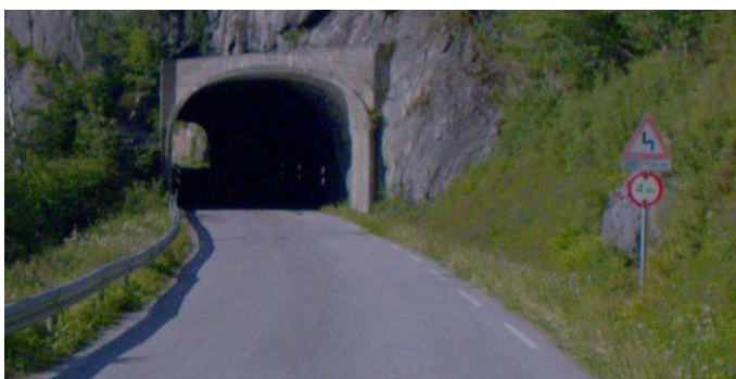
Figur 6 Berdaltunnelen, lengde 130 meter (vegbilder/vegkart.no 2020)
