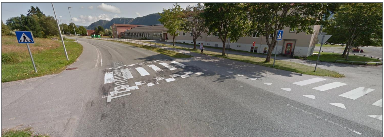
Figur 3 Opphøyd gangfelt og fartsgrense 40 km/t på fv. 680 ved Sodin skole. Ledegjerde mellom gs-veg og kjørebane (Google Street View 2019)
