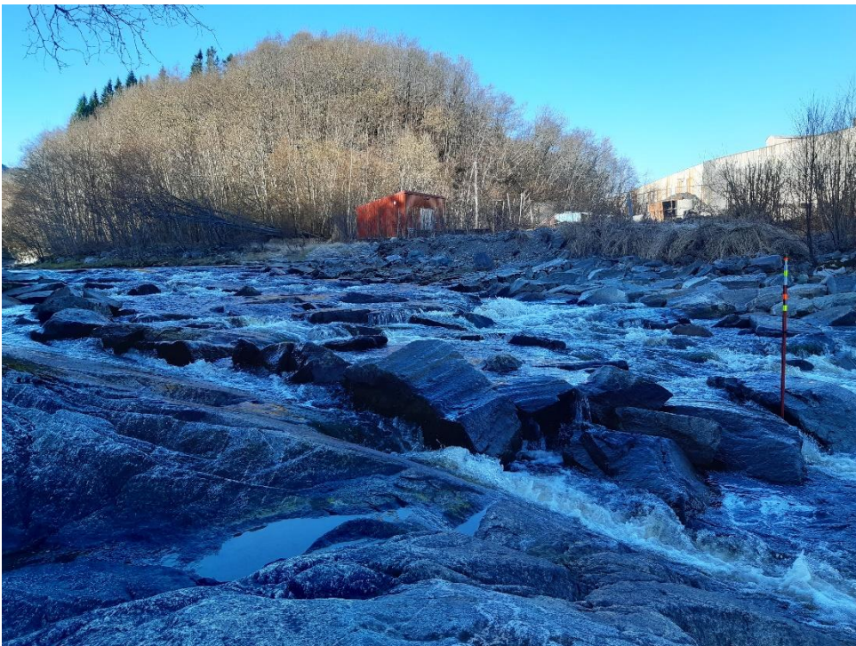
Figur 5: Høydeforskjellen på terskelen ser ut å være ca. 2 meter over ca. 26 meter. Foto: Martin Georg Hanssen fra Heim kommune.
