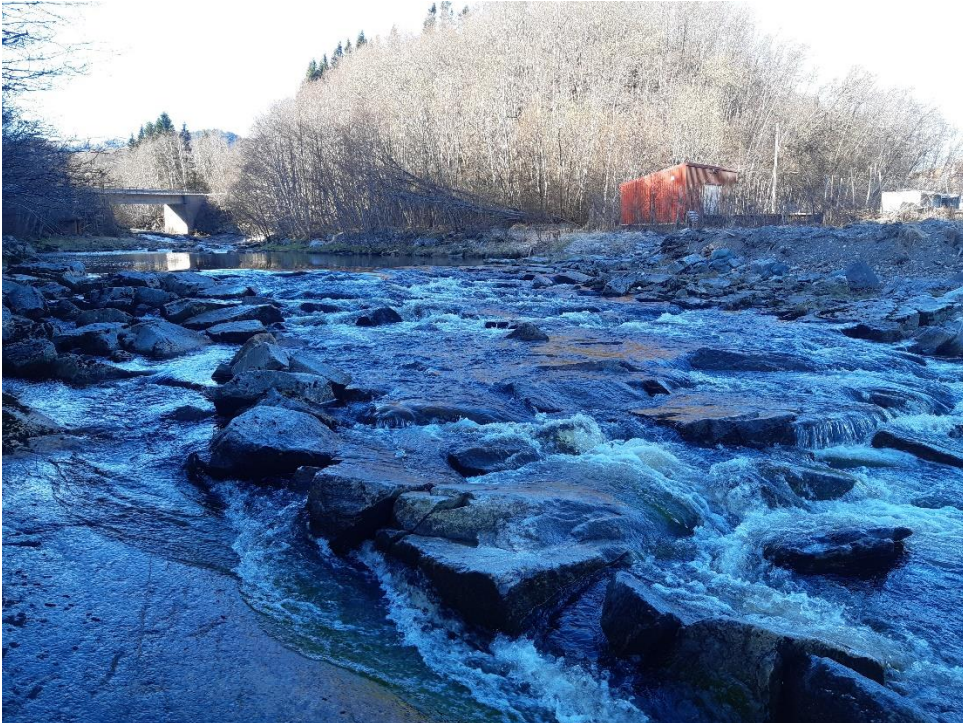
Figur 4: Terskelen ser ut til å bestå av store og grove steiner uten noen utpreget renne som fisken kan vandre gjennom ved lav vannføring. Foto: Martin Georg Hanssen fra Heim kommune.
